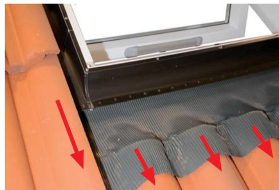
La lunghezza del piombo plissettato è di 33 cm di cui 29 utili. Il raccordo è dotato di grembialina in piombo nella parte bassa per il sormonto delle tegole o coppi.
